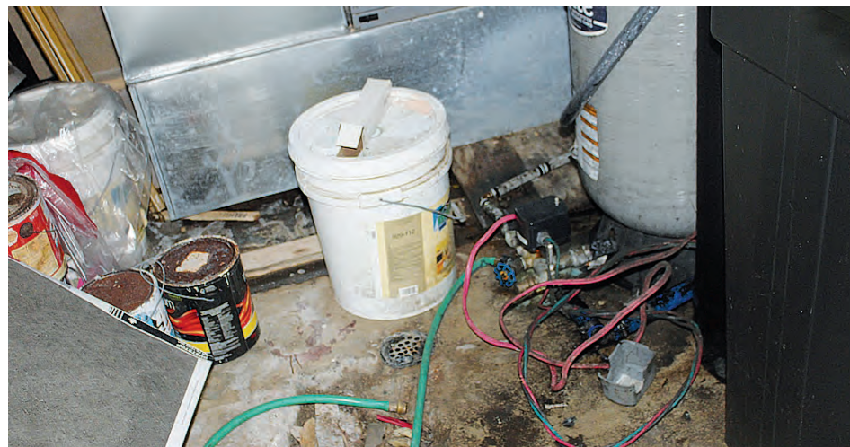
Photo Stéphane Tremblay Le sous-sol est dans un état lamentable.
