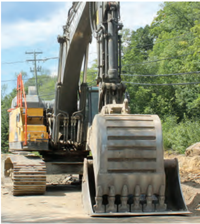
SAINT-JÉRÔME UN VASTE CHANTIER DÉBUTE SUR LAJEUNESSE
