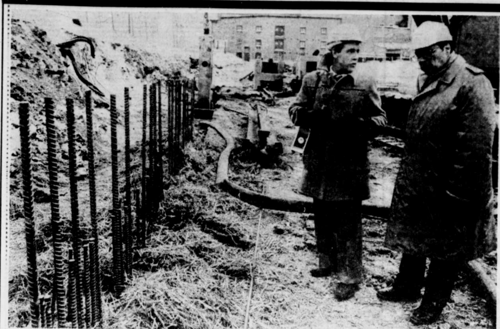
L'ingénieur Germain Dupont (à gauche), près d'une partie du mur d'étalement de béton armé moulé qui protégera le sous-sol du Musée de la civilisation des infiltrations d'eau du fleuve.
