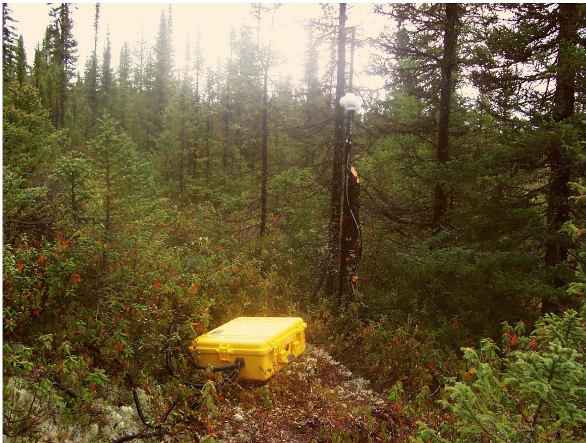
Figure 3 : Installation typique de la station de base
