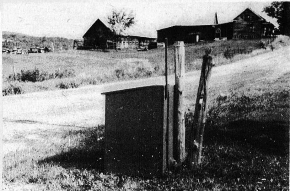
Un modèle des réceptacles déjà installés en bordure de la route, à Saint-Charles, et que toutes maisons d'été devront avoir, en vertu du nouveau règlement.
