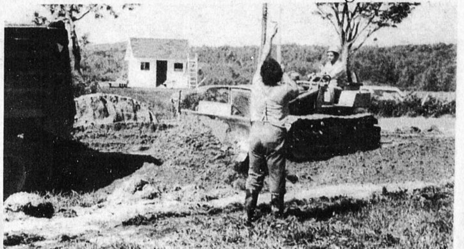
La paroisse Saint-Gabriel a procédé, la semaine dernière, à des travaux visant à modifier le chemin du 5e rang. L'inspecteur Gilles Sarrazin a expliqué qu'il s'agissait d'éliminer une courbe.
