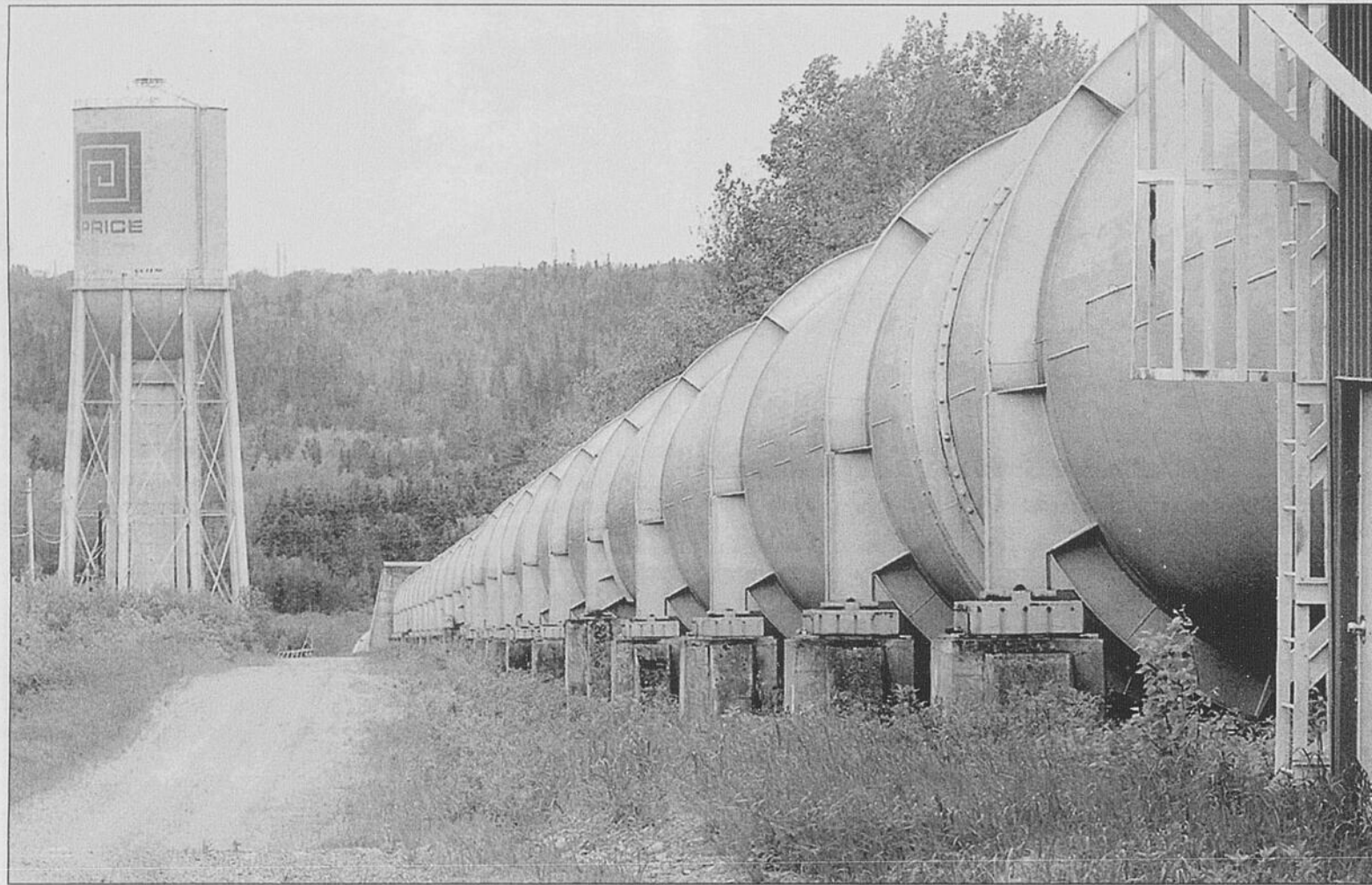
REEMPLACEMENT - Abitibi-Consolidated réalise les études techniques en vue de remplacer la conduite forcée de la centrale Murdock-Wilson. Il s'agit d'un tunnel de bois de 1,6 kilomètre qui alimente le groupe-turbine de la centrale à partir de la rivière Shipshaw.
