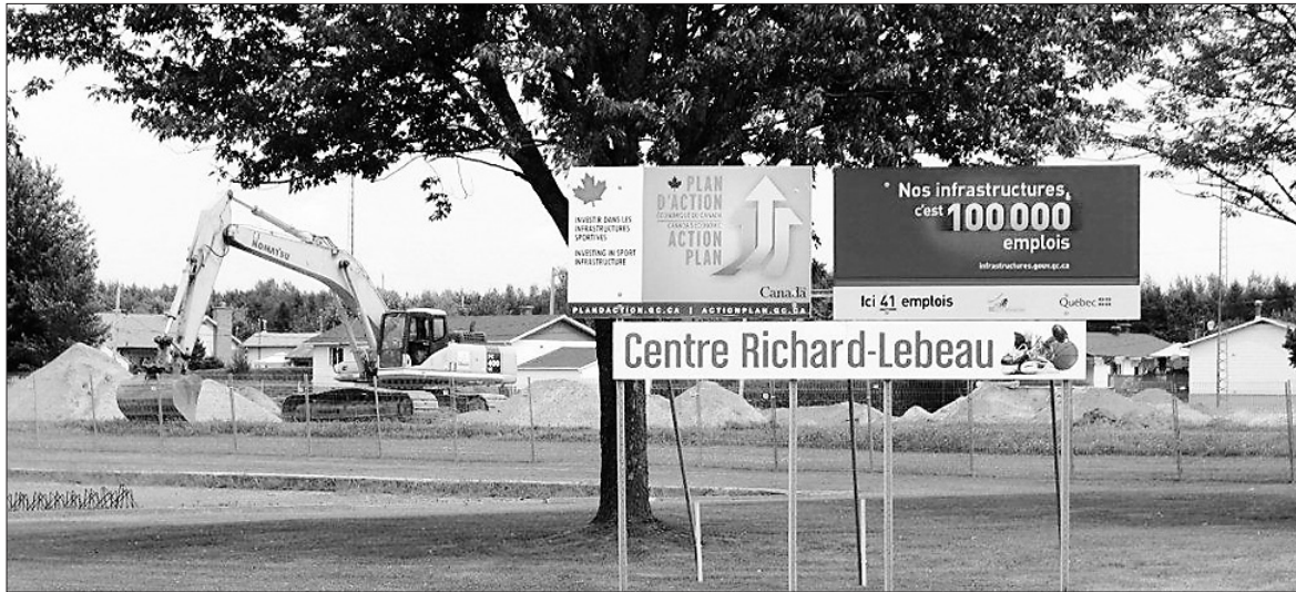
Les travaux sont commencés sur le chantier de construction du Centre Richard-Lebeau, situé sur le terrain voisin de l'école secondaire La Découverte, à Saint-Léonard-d'Aston.
