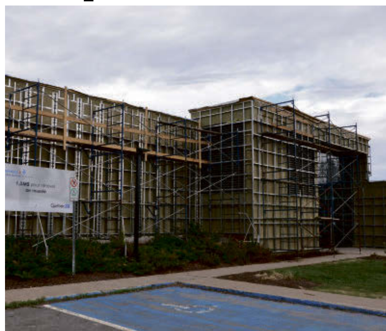
Le Musée régional de la Côte-Nord est ceinturé d'échafaudages en attendant la pose du nouveau revêtement extérieur. (Photo: Le Nord-Côtier)
