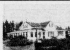
PONT-ROUGE , entièrement renoué, rez-de-chaussée, aires ouvertes, planchers chêne, 4 chambres, Henri Paquet 525-9198, 653-1236
