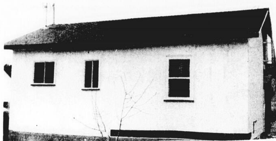
Le mât de branchement sur ce chalet est toujours inutile mais son propriétaire visiblement espère pouvoir se brancher bientôt.
