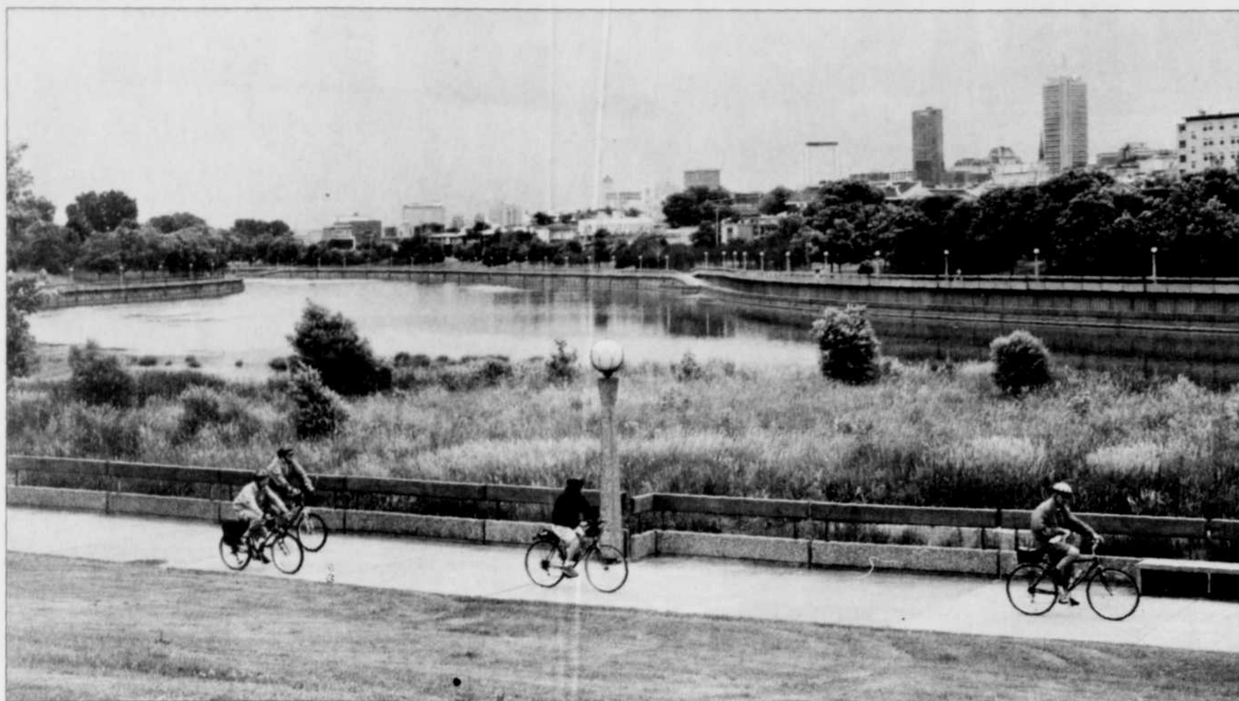
Il faudra démolir les berges de béton du côté sud de la rivière, entre Scott et le méandre Marie-de-l'Incarnation, pour y intégrer un long bassin souterrain.
