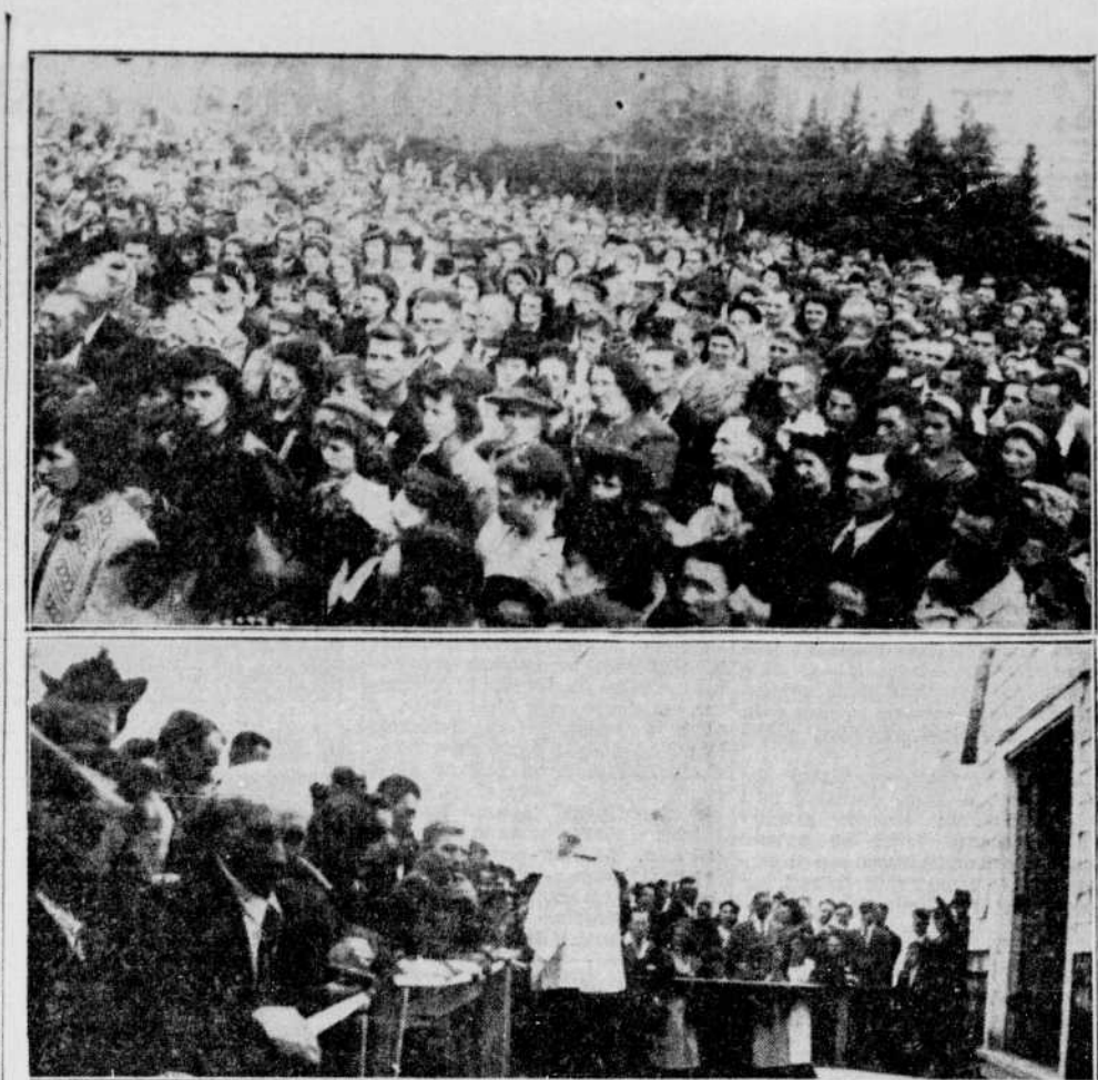
A St-Joseph de la Montagne — Ces photographies ont été prises sur la montagne de St-Joseph à St-Léon de Val Racine, lors du pèlerinage annuel des diocésains de Sherbrooke. Celle du haut fait voir une partie de la foule pendant le sermon que prononçait Son Excellence Monseigneur Philippe Desrain.
