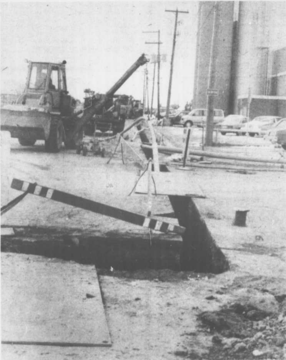
Rue Léveillé dans le parc industriel de Terrebonne, les travaux d'installation des conduites du réseau de Gaz Métropolitain se terminaient la semaine dernière et l'ouverture des valves se produisait vendredi le 2 décembre. Il faudra attendre que la clientèle se manifeste pour que la phase II vers le parc industriel de la section St-Louis ne démarre.
