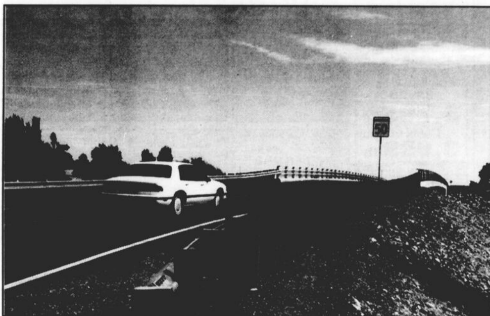
Une semaine après avoir annoncé que son ouverture était temporairement retardée, le ministère des Transports a fait savoir que ce pont qui enjambe la rivière Châteauguay est accessible aux véhicules et ce, pendant que des travaux de consolidation y seront effectués. (photo J.T.)
