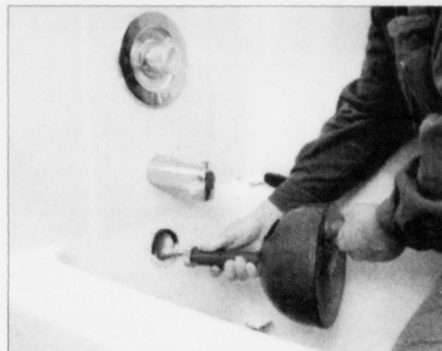
La débouchoir à dévidoir, d'accord. Mais il arrive qu'une poussée d'air sous pression fasse bien mieux le travail.
