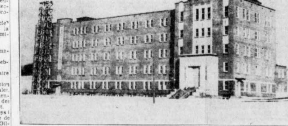
Mont Ste-Anne — Cette photo représente la maison des missionnaires de Mariannahill du Mont Ste-Anne de Sherbrooke, maison qui fut commencée en avril 1947 et qui ne sera terminée qu'après encore des mois de travail. L'édifice sera de style néo-gothique, inspiré de l'architecture de M. André Royer, architecte de Sherbrooke.
