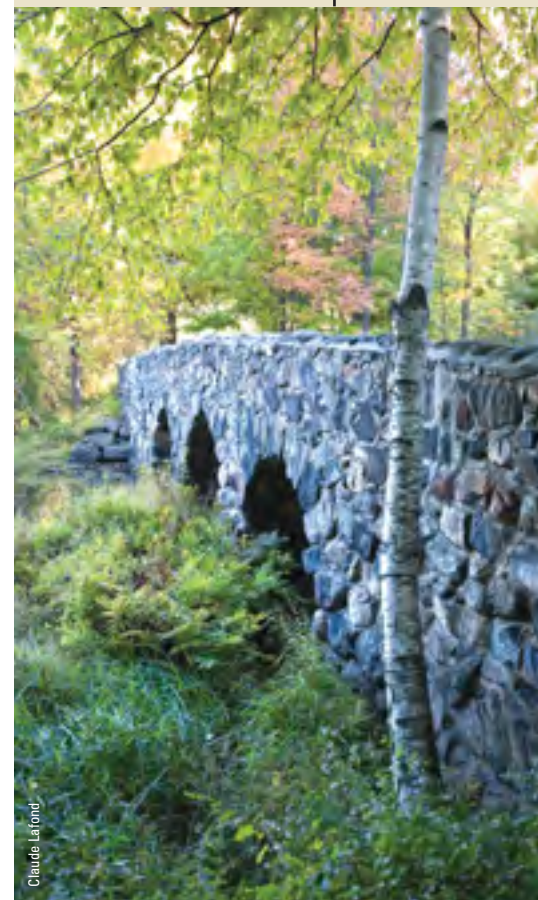
PONT DES TROIS ARCHES
