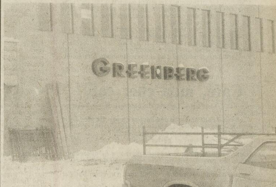
Depuis quelques jours seulement, la facade du Domaine du Parc, en bordure de la rue Principale ou plus exactement de ce qu'il en reste, s'orne d'une annonce qui retient l'attention de plus d'un Cowansvillois.
