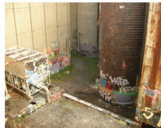
Vue vers la cour intérieure
