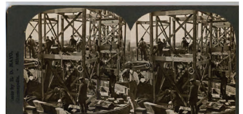
Construction de silos en terracotta par la firme Barnett and Record Co. Minneapolis, 1900-1910
