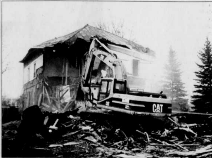
Démolition du presbytère de Saint-Justin le printemps dernier.
