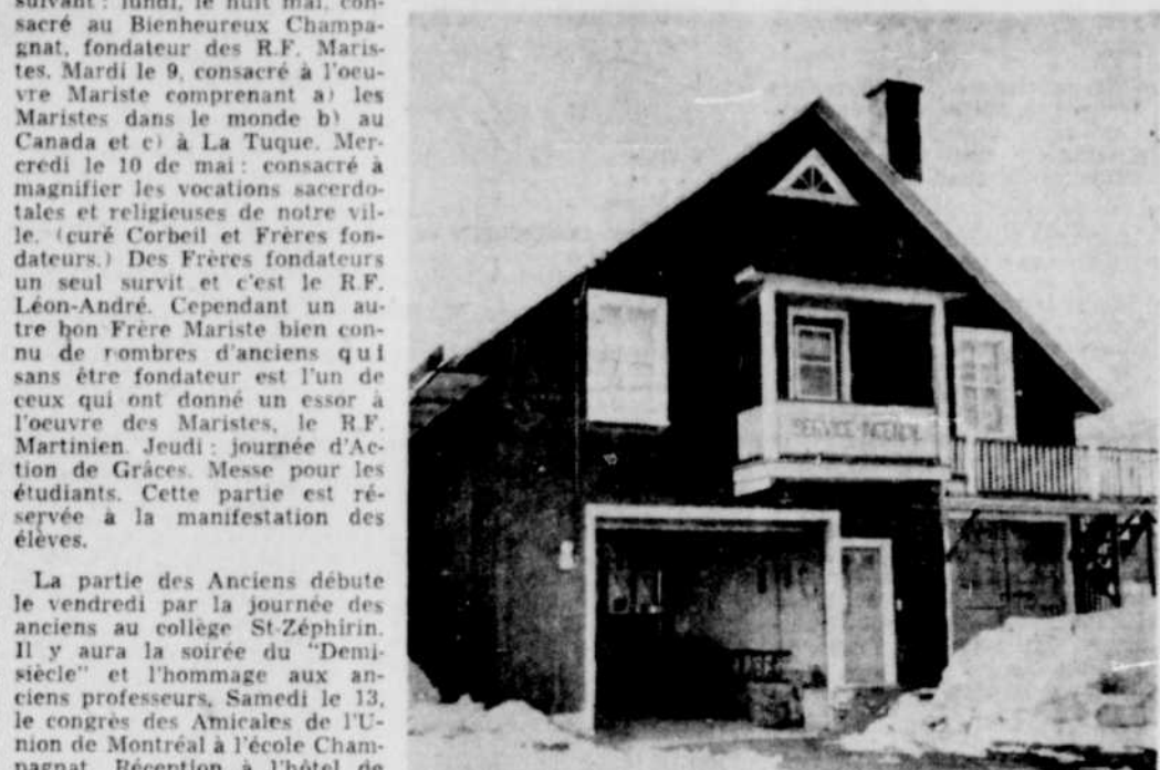
LA CASERNE DES pompiers volontaires de St-Marc des Carrières. Une ancienne maison qui a été transformée grâce au travail des volontaires.
