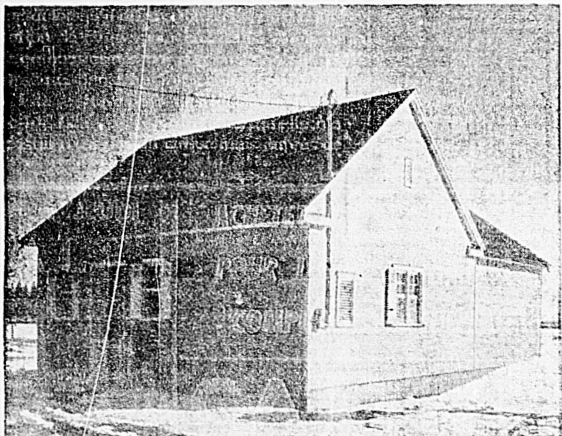
VOICI LE NOUVEAU CENTRAL automatique de St-Ambroise qui desservira les 400 usagers du téléphone de cette municipalité.
