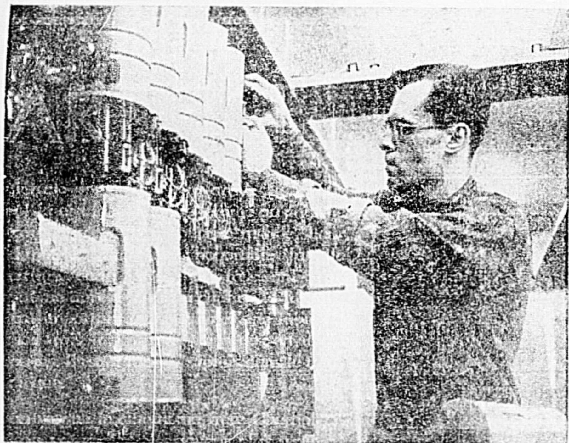
LES CHERCHEURS DE LIGNES sont très importants dans un central automatique puisqu'ils attribuent à l'usager le numéro qu'il a composé.
