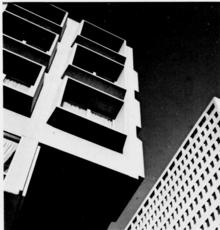
Profils de béton, Place de l'Assomption, Moncton, N.-B.
