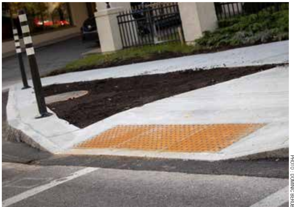
Le « curb cut effect » tire son nom des abaissements de trottoirs destinés à l'origine à faciliter l'accès aux personnes en fauteuil roulant.
