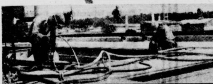
40,000,000 verges de pieds de boyaux de fabrication Dominion Rubber furent utilisés lors de la construction de ce puissant ouvrage.
