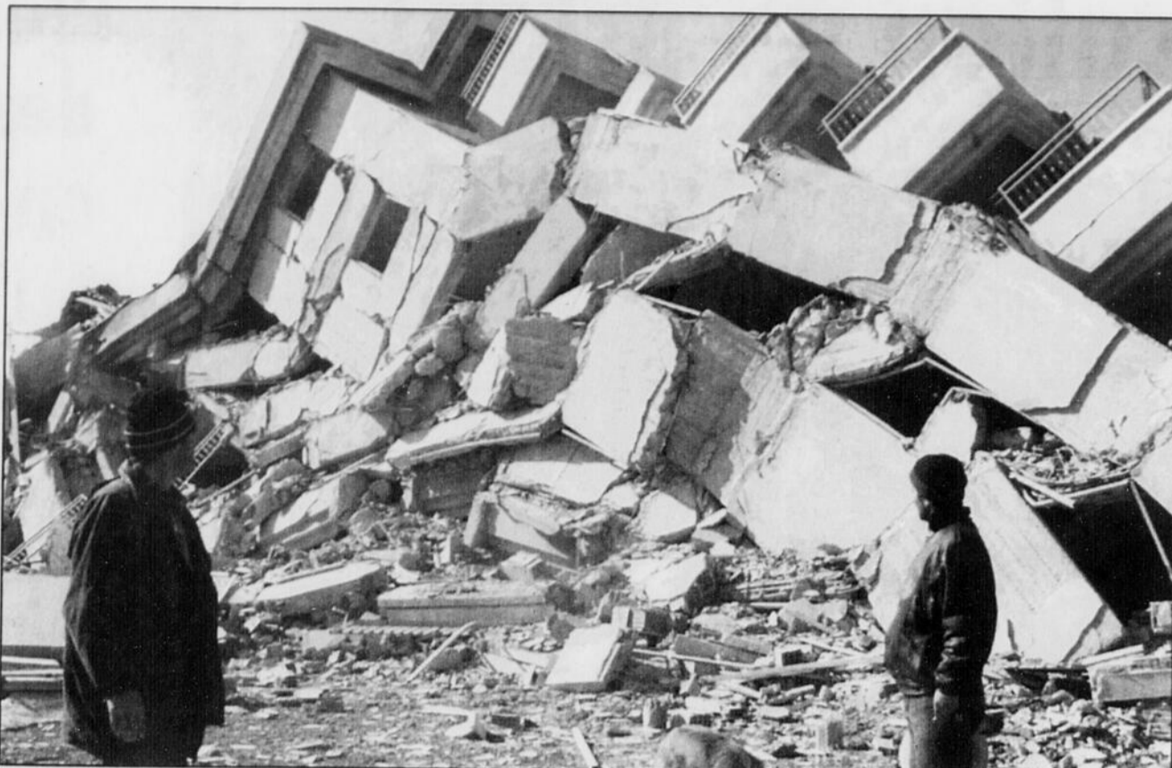
Des survivants contemplent les ruines d'un édifice écroulé, dans la ville de Cay, après le séisme qui a dévasté le centre de la Turquie et notamment la province de Afyon, faisant au moins 45 morts.
