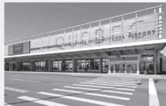
Aéroport international Jean-Lesage de Québec 500, rue Principale Arrondissement Laurentien Rénovation
