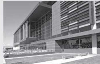
Pavillon Ferdinand-Vandry 1050, avenue de la Médecine Arrondissement de Sainte-Foy-Sillery Agrandissement
