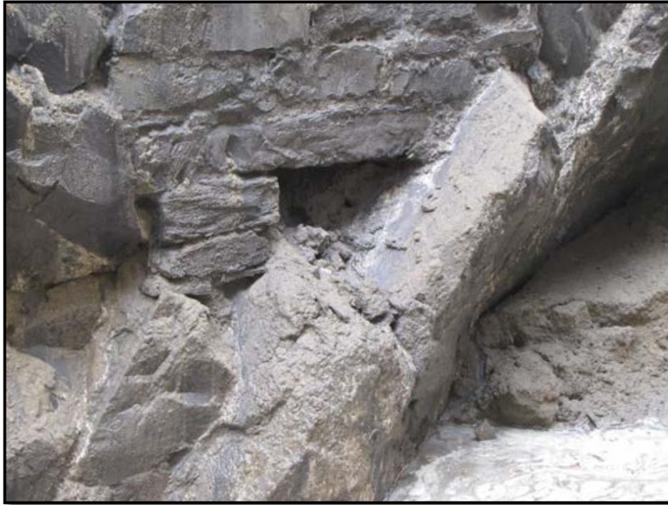
Figure 59. Vue détaillée de l'ouverture à la base du parement oriental de la citerne. En direction est, photo Serge Rouleau, A14-10-13.
