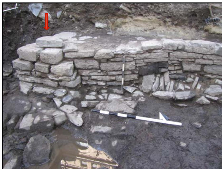
Figure 61. Assemblage d'assises à l'extrémité ouest du mur nord de l'entrée principale. En direction nord, photo Serge Rouleau, A14-15-05.
