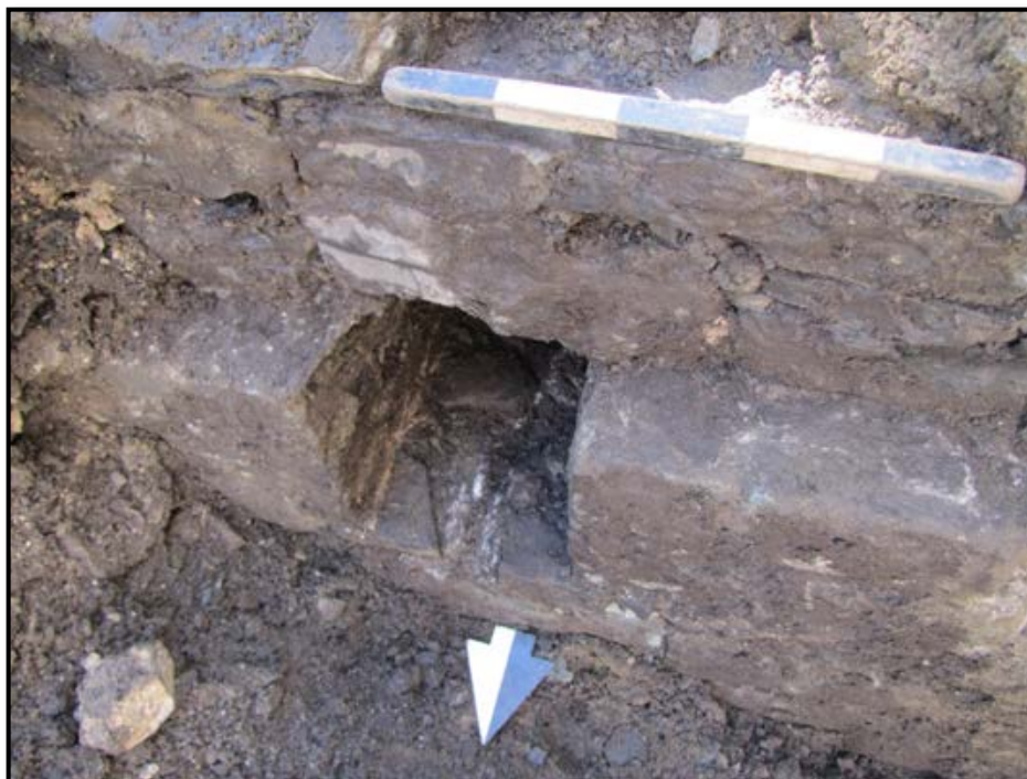
Figure 76. Vue d'une ope dans la paroi nord de la citerne des casernes. Prise de vue du parement extérieur. En direction sud, photo Serge Rouleau, A14-11-35.
