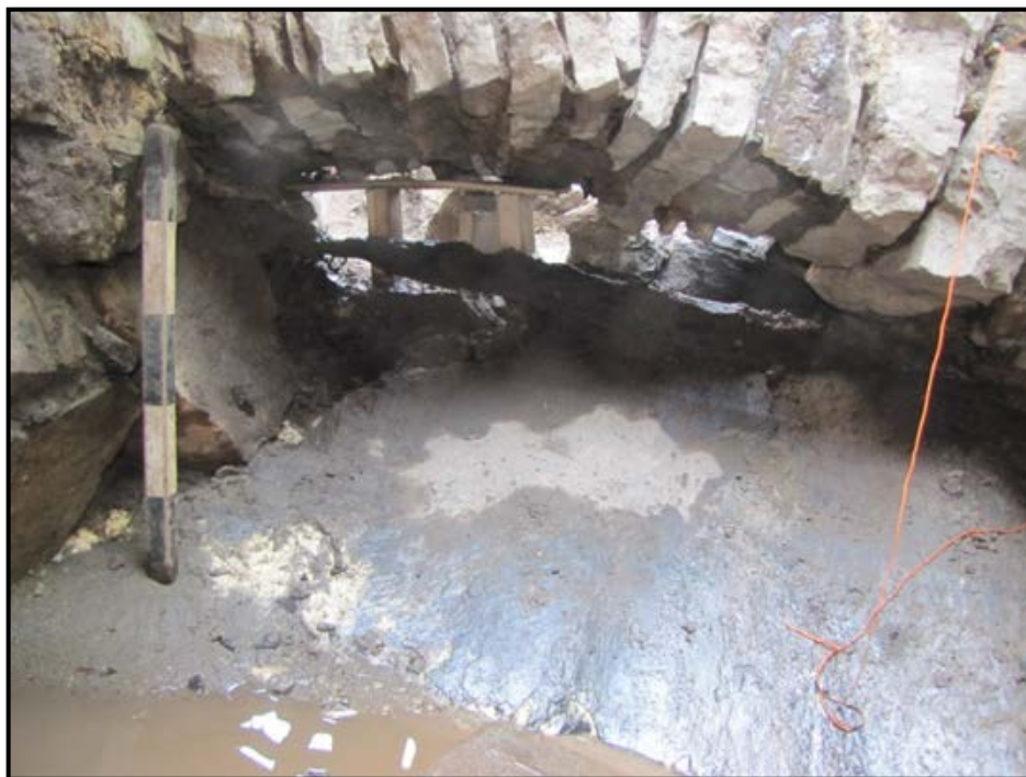
Figure 40. Arc dans la paroi nord de la citerne 12H18. Notez la paroi rocheuse plus haute sous l'arc. En direction nord, photo Serge Rouleau, A14-08-19.
