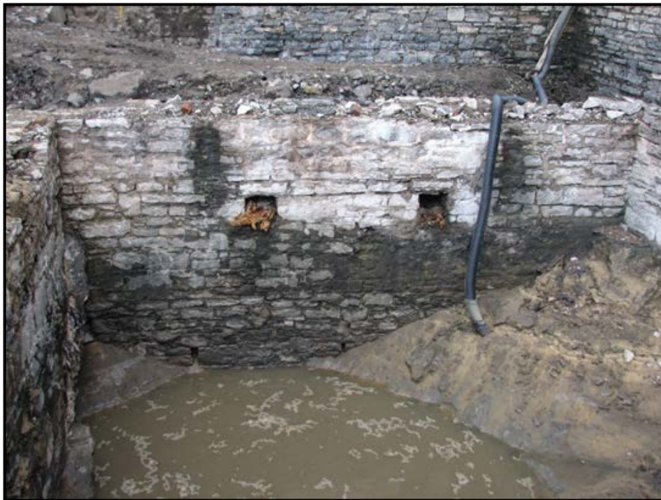
Figure 75. La paroi sud de la citerne des casernes des Jésuites 12B2. Notez les ouvertures à la base de la paroi. En direction sud, Photo Manon Goyette, A14-18-19.
