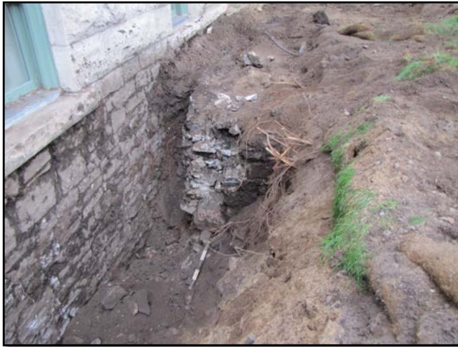
Figure 48. Vue du parement sud du vestige 13F1. En direction nord, photo Serge Rouleau, A14-10-35.
