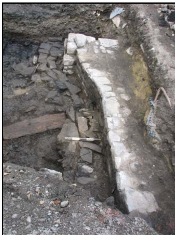
Figure 64. La canalisation 12N45 sans les pierres 12N105. En direction ouest, photo Manon Goyette, A14-19-45.
