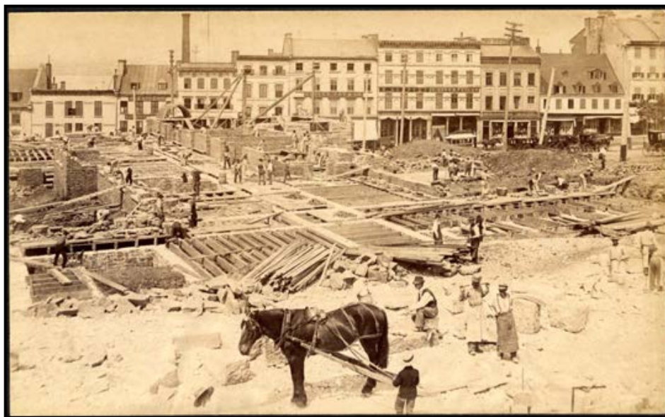
Figure 14. La construction de la façade de l'hôtel de ville en 1895. Archives de la Ville de Québec.
