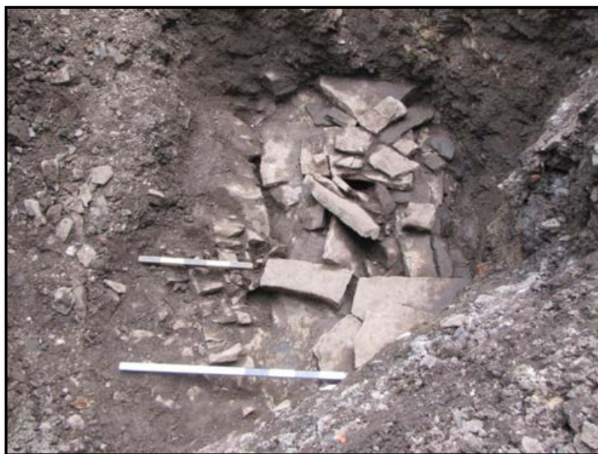
Figure 53. Le vestige 13C1 découvert fortuitement lors des travaux d'aménagement. La canalisation fut aménagée entre deux crans de roc. En direction sud, photo Serge Rouleau, A14-12-14.
