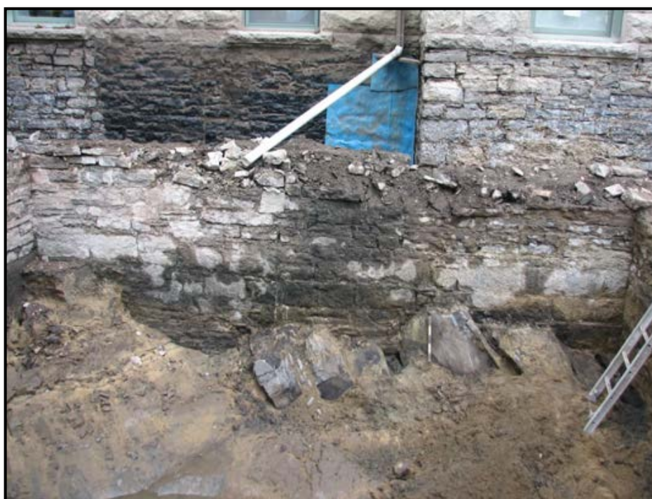
Figure 77. Paroi ouest de la citerne des casernes. En direction ouest, photo Manon Goyette, A14-18-06.
