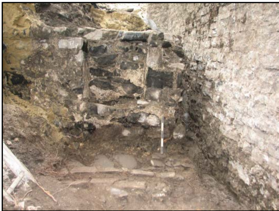
Figure 46. Vue du parement nord du vestige 12K100 dégagé lors de la surveillance des travaux. La cavité 13B100 est aménagée dans le parement de la fondation. En direction sud, photo Manon Goyette, A14-18-33.
