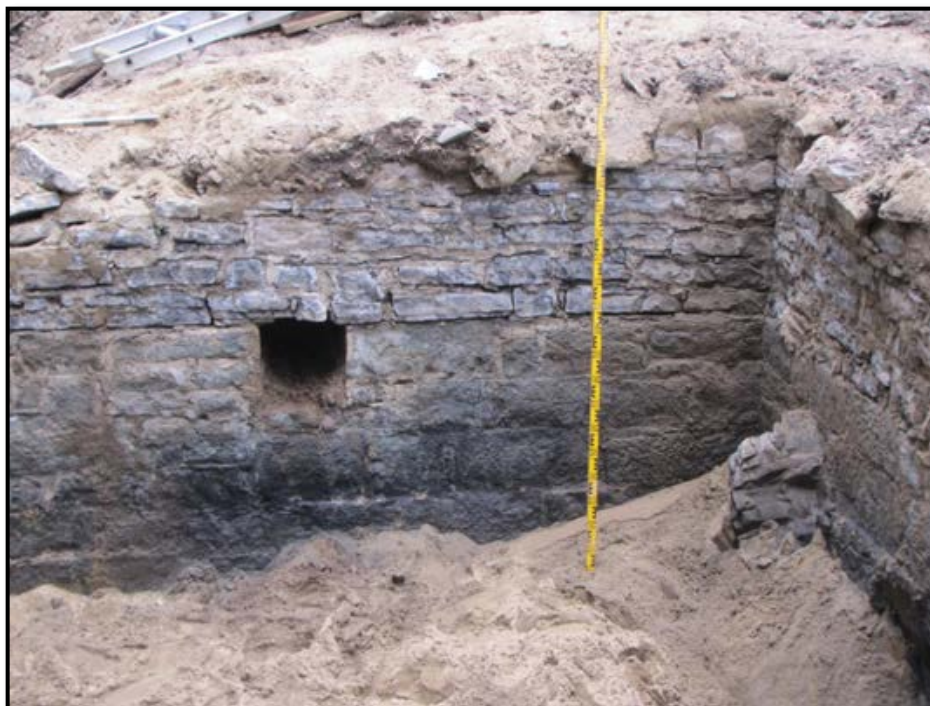
Figure 97. Parement de pierre calcaire visible dans la portion supérieure de la paroi nord de la citerne (12B2). En direction nord, photo Serge Rouleau, A14-10-05.
