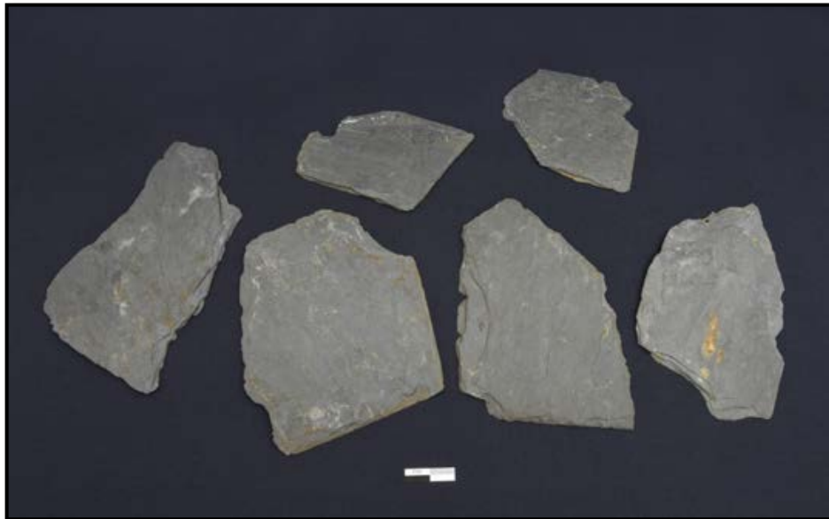
Figure 67. Fragments d'ardoise provenant de la toiture. Photo Chantal Gagnon.
