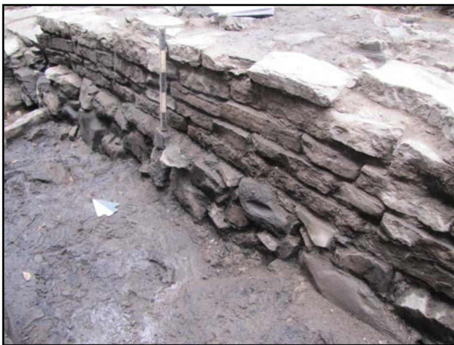
Figure 32. Vue du parement extérieur (ouest) de la fondation du mur ouest du collège 12N101. En direction nord-est, photo Serge Rouleau, A14-16-29.
