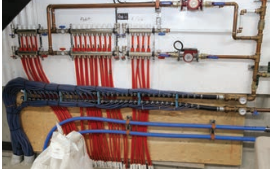
Le plancher radiant de la laiterie et du robot de traite est chauffé grâce à l'eau qui circule dans des tuyaux sous le compost et à la chaleur que celui-ci dégage.
