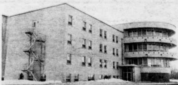
ANCIENNE RESIDENCE — L'ancienne résidence des religieuses du Bon-Pasteur, à l'École Lafontaine, pourrait être entièrement réaménagée si le projet de $320,000, présenté par la direction de l'école, est accepté par le ministère de l'Education.
