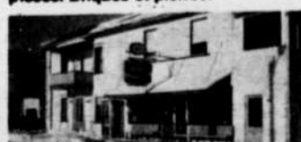
Boul. Niquet, village Périlbonka; édifice commercial, résidence, logements, restaurant licencié.
