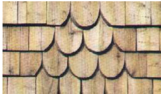
Photo 7 : Parement extérieur, y compris des coupes spécialisées
