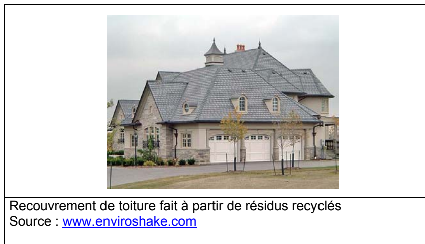
Photo 12 : Recouvrement de toiture avec un matériau écologique
