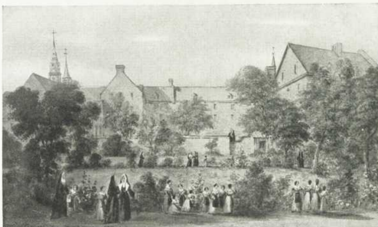
Maison Mère construite en 1684.
