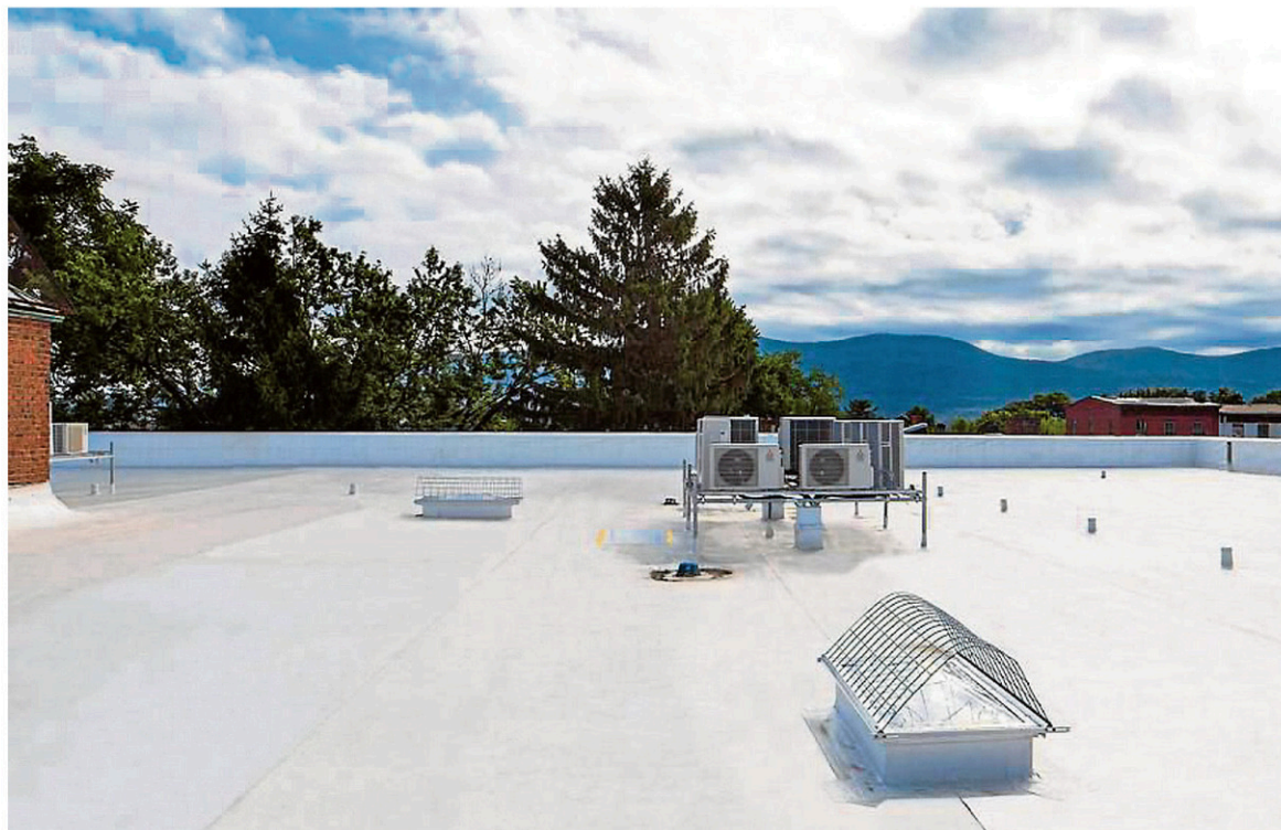
La méthode de l'ingénieur civil Hashem Akbari permet de réduire à trois jours la période nécessaire pour tester la performance des matériaux qui constituent les toits réfléchissant la lumière. — PHOTO FOURNIE PAR DURO-LAST
