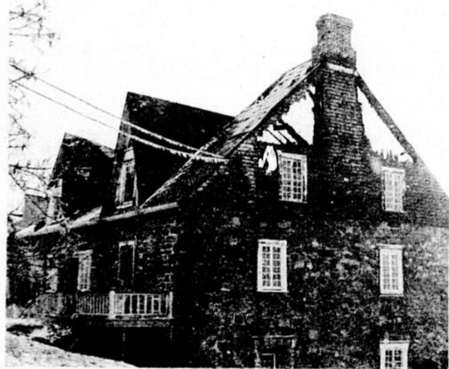
Le 20 novembre dernier, un incendie a complètement ravagé le moulin banal situé sur l'avenue des Canotiers à proximité de la chute de la Rivière-du-Sud à Montmagny. Rappelons que cette construction de près de 130 ans devait être classée sous peu monument historique.
