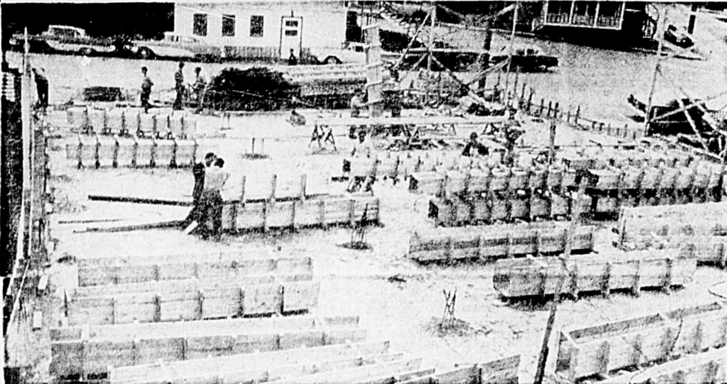
CE CHANTIER est celui de la construction d'un garage et d'une salle de montre d'auto présentement en cours sur la rue Hôtel-Dieu. L'édifice à deux étages est érigé par le compte de Legare Auto Ltée. Les travaux ont débuté il y a trois semaines et une trentaine d'ouvriers y sont à l'ouvrage. La façade principale donnera sur la rue Hôtel-Dieu. Le nouvel édifice est contigu à l'ancien garage d'autobus au Legare Auto à aménagé une salle de débarras au second étage, un atelier de mécanique au premier, et un entrepôt pour les pièces d'auto et autos usagées au rez-de-chaussée. Sur cette photo, les ouvriers se préparent à ériger le second étage. (Photo Le Progrès par E. Bonneau)
