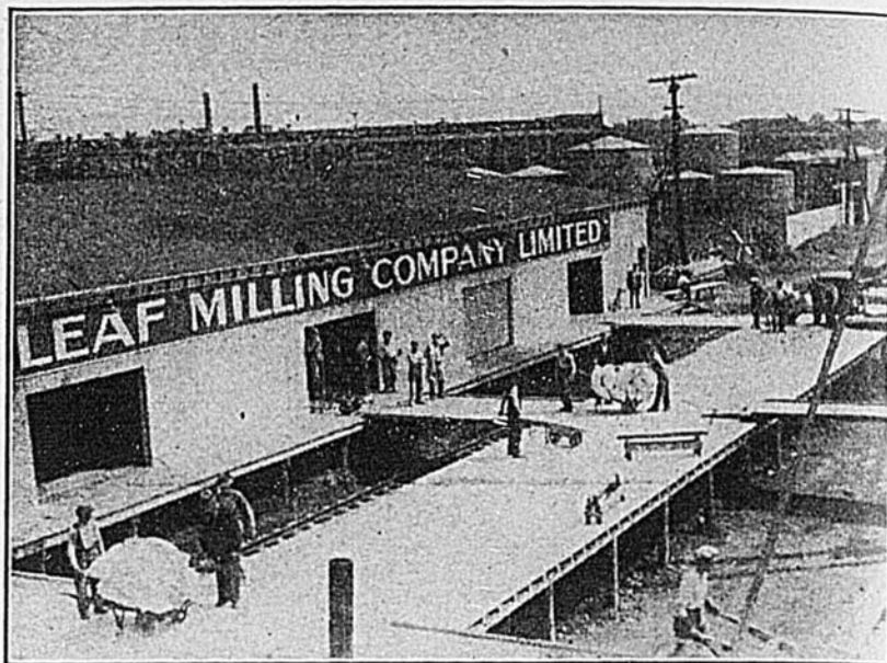
Cette photographie montre le nouvel entrepôt de la Maple Leaf Milling sur le Canal Lachine, à Montréal. Cet entrepôt a une capacité de 50,000 sacs. L'avantage de cette nouvelle installation est de combiner le transport par rail et par eau car la voie ferrée passe en arrière du bâtiment. Ce nouvel entrepôt a été inauguré par la compagnie à la fin de juillet.
