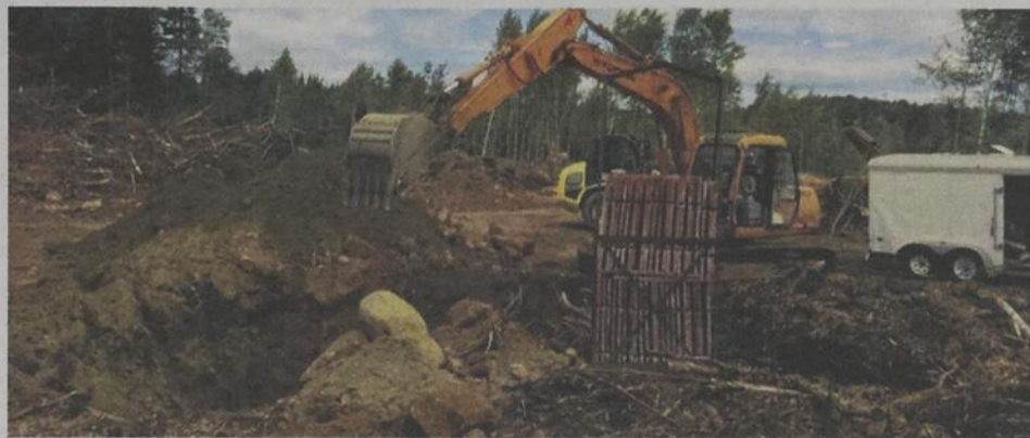
Déjà, les travaux du parc récréatif ont été entamés et devraient s'achever à l'été 2013.
