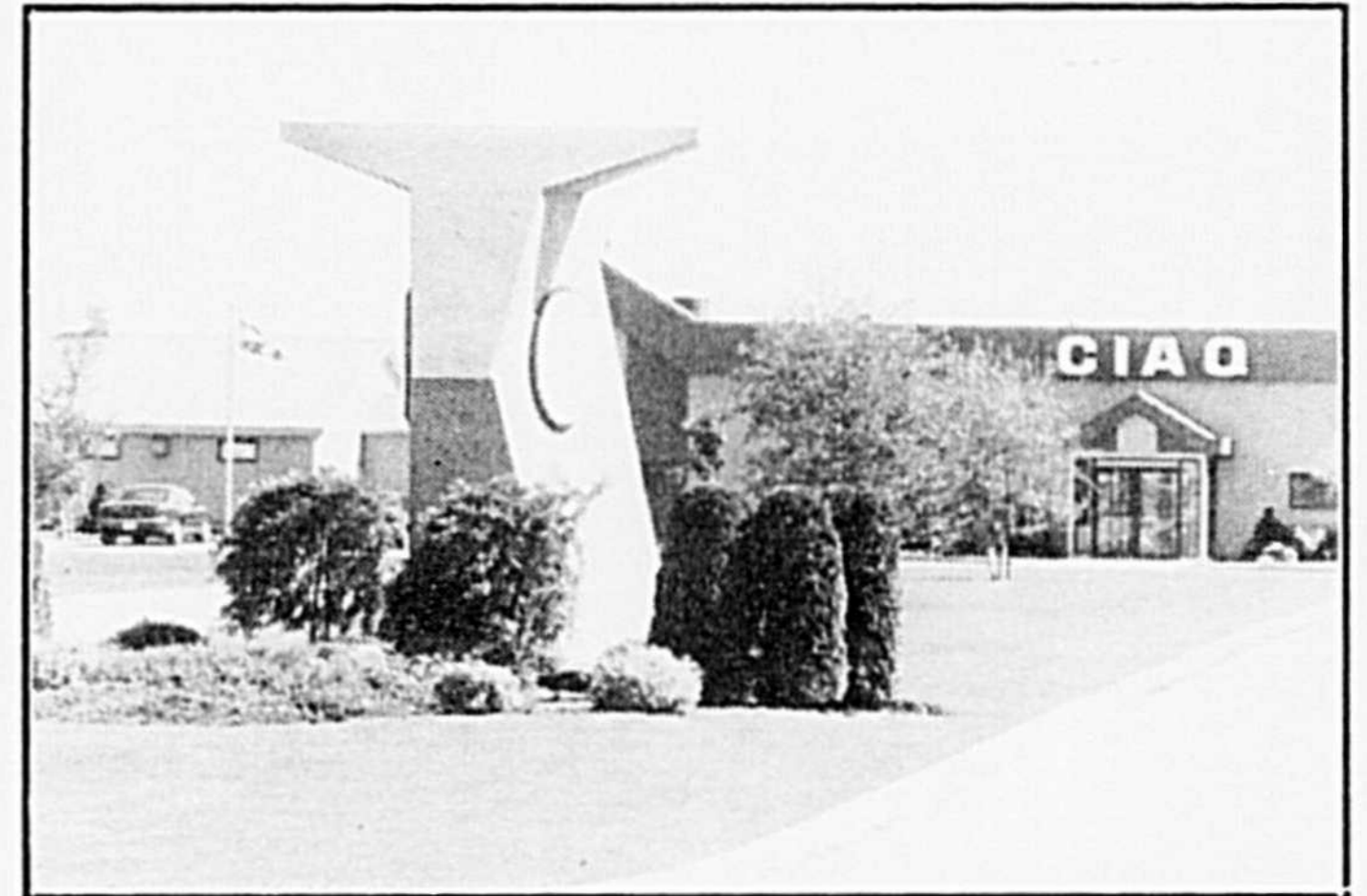
Le CIAQ possède d'importantes installations pour l'élevage et la vérification des aptitudes des taureaux en bordure de la route 116. (Photo PPM)
