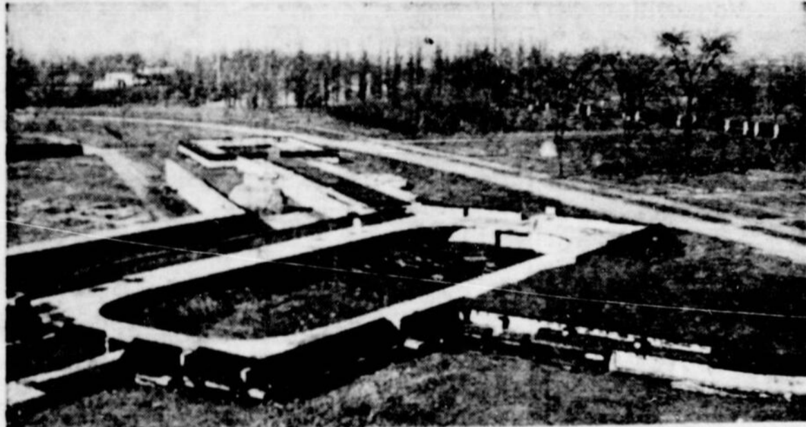
Les fondations des grandes serres au Jardin Botanique sont en parfaite condition et prêtes à recevoir les structures métalliques. Dans la sorte d'arène que l'on voit au centre, sont empilées des tonnes de poutres métalliques rongées par la rouille.
