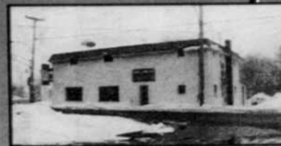
Waterloo, rénové 1978, 2 étages de 2 100 pi.ca. Prox. sacrifice, faite une offre.
