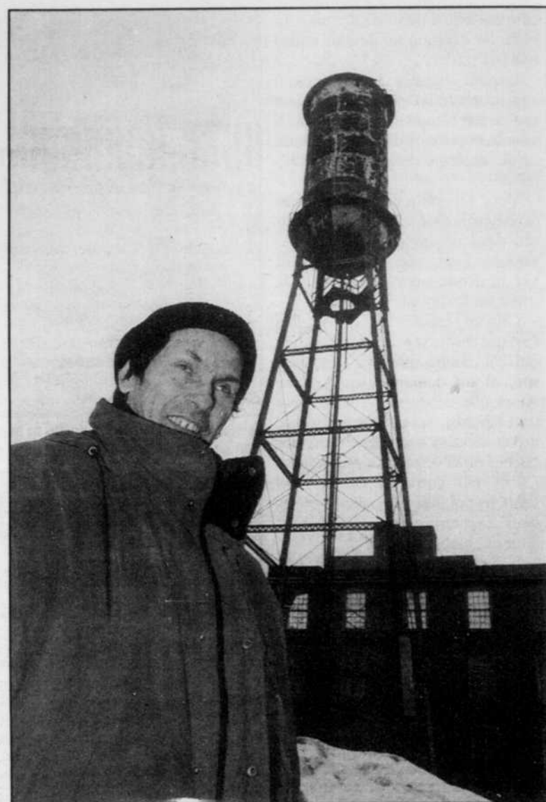
Pierre Tardif, l'un des artistes qui souhaitent conserver la «tour Eiffel de Granby», devant le château d'eau qui risque de tomber sous le pic des démolisseurs.
