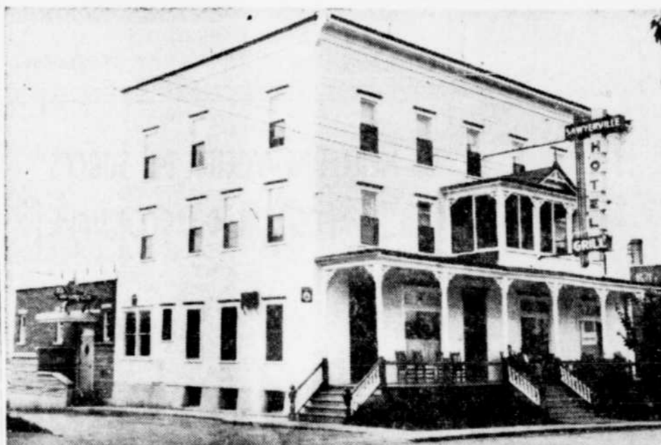
Cette photo montre, au premier plan, l'hôtel Sawyerville tel qu'il apparaît maintenant. A l'arrière, dans le coin gauche, on remarque la nouvelle annexe avec son entrée
