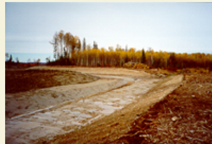
Les travaux d'excavation du « nouveau » ruisseau Pandora.
