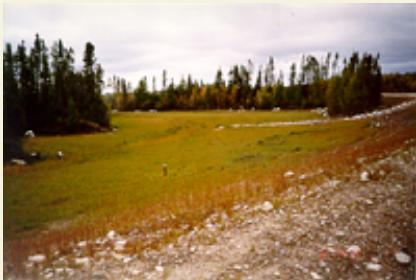
Voici le site Lorraine, une fois les travaux complétés.
