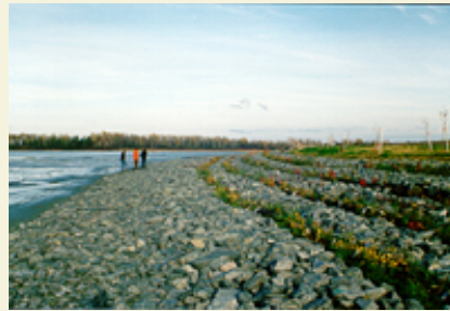
La stabilisation de la berge joint les techniques de stabilisation mécanique et végétale
