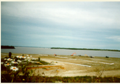
Et voici le même site, pendant les travaux de restauration en 2000.
