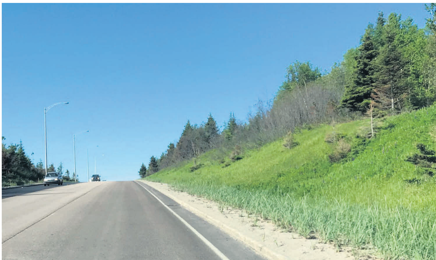
D'ici à la fin du mois d'octobre, les cyclistes n'auront pu à monter la dangereuse côte Manic-1. Une piste cyclable est en construction à l'extérieur de la route 138.
