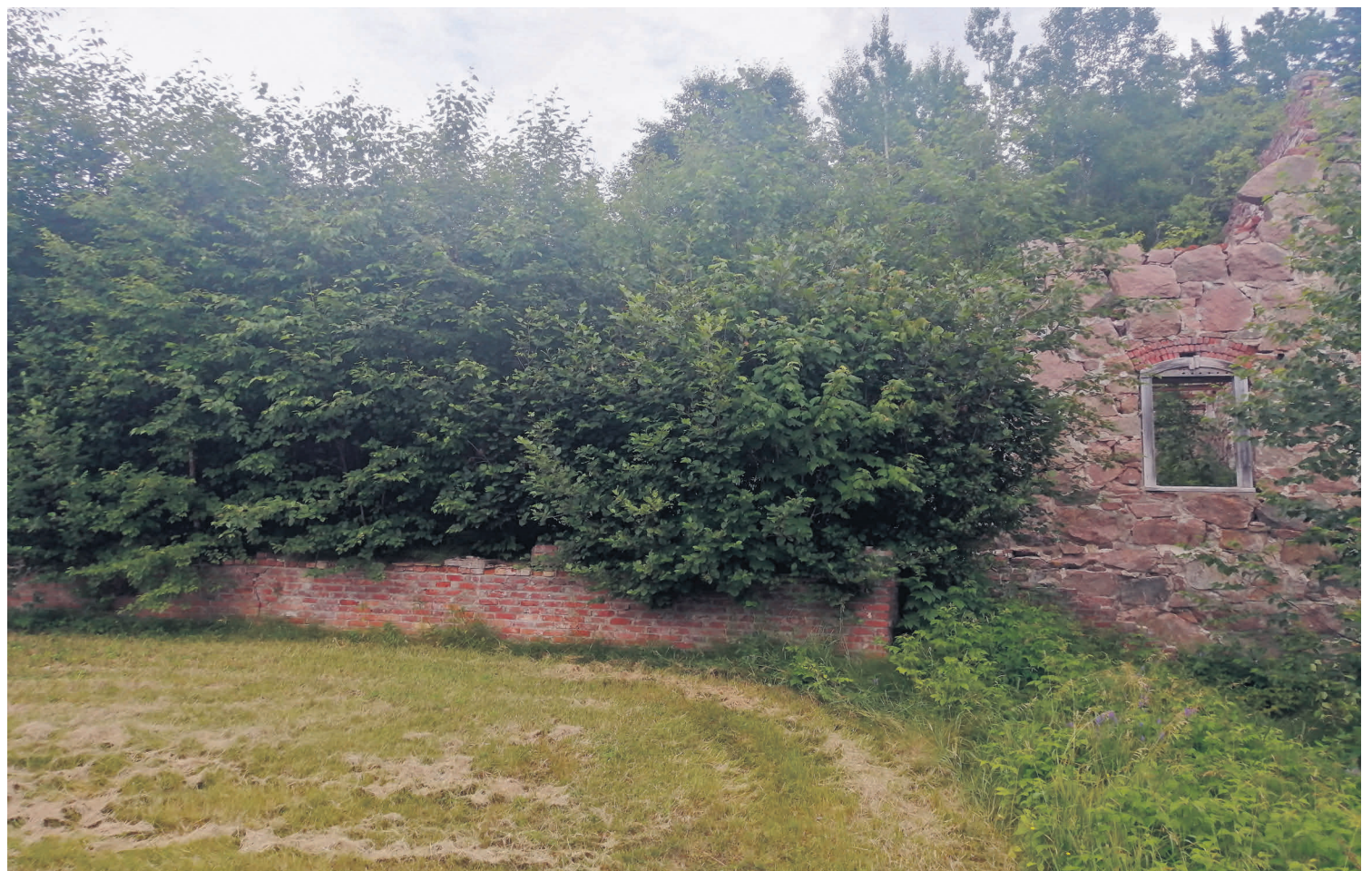
L'ancienne scierie présente sur le site historique de Rivière-Pentecôte est de moins en moins visible en raison de la végétation.
