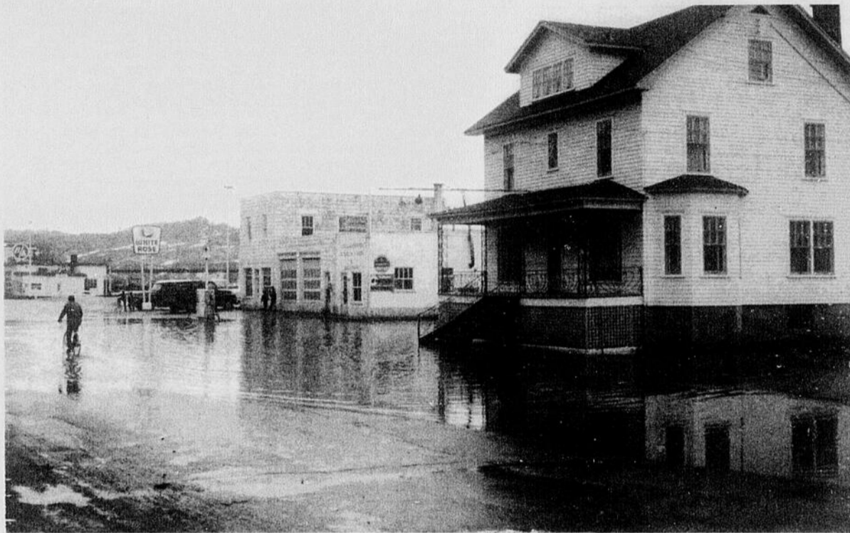
UNE DEBACLE sans inondation à Beauceville ne serait pas une vraie débâcle! La Chaudière s'est donc permise une petite incursion sur la première Avenue au début de la semaine. A deux reprises, les eaux ont envahi certaines sections de cette
