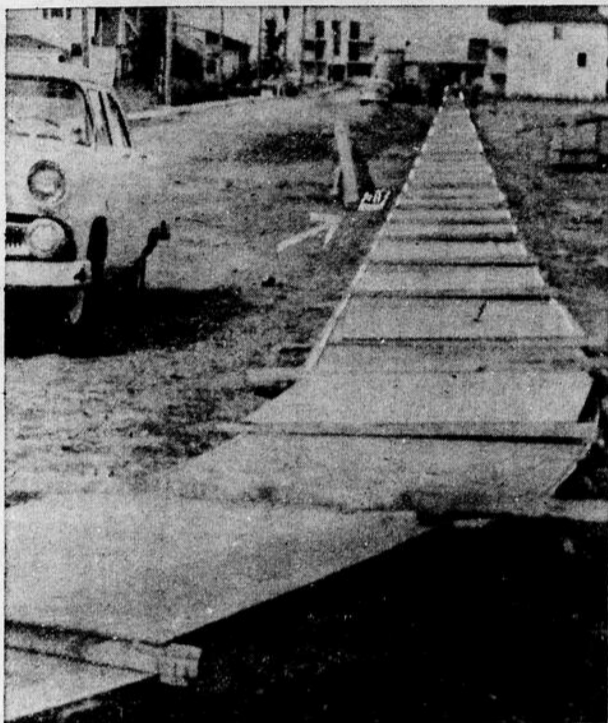
L'aspect du trottoir tel qu'on le construit actuellement. On remarquera qu'il va maintenant en ligne très droite, avec une seule courbe près de la maison de M. Laurent Després pour rejoindre l'ancien trottoir construit depuis plusieurs années. La flèche au centre, indique la bouche d'égout qui est maintenant en dehors du trottoir.
