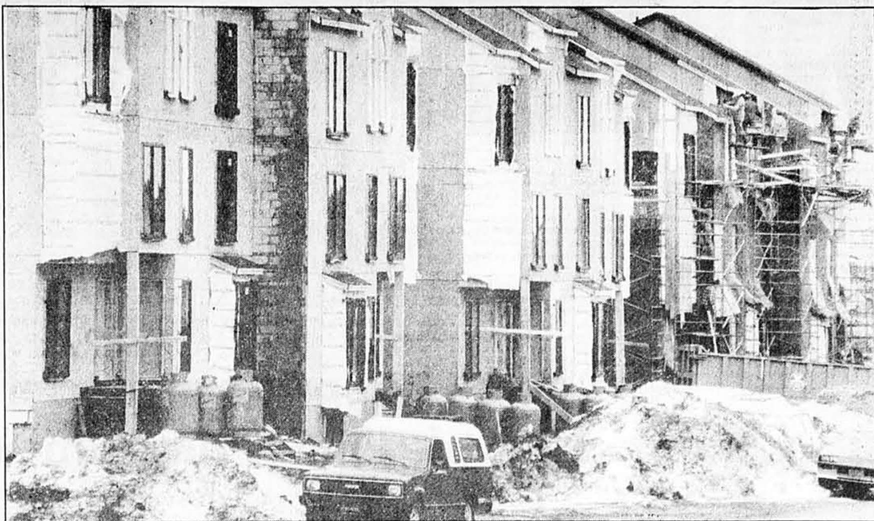
On assiste à une reprise de la construction de petits immeubles de deux à six logements, soit des duplex et triplex. Plusieurs entrepreneurs auparavant spécialisés dans la construction de maisons
