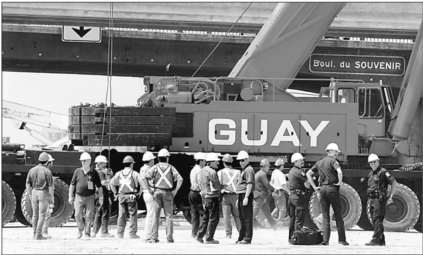
Les responsables du démantèlement du viaduc de Laval ont dû utiliser une grue géante pour déplacer les poutres de béton.
