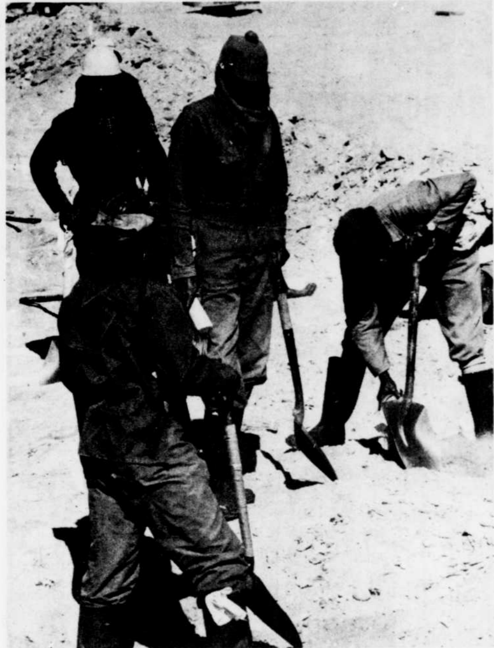
Les mineurs nettoient la surface rocailleuse afin de ne pas y laisser la moindre matière pouvant contenir des diamants.
