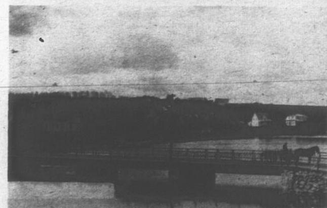
Un deuxième pont est apparu au début du siècle érigé sur piliers de ciment, armature en fer et pavé de bois.
