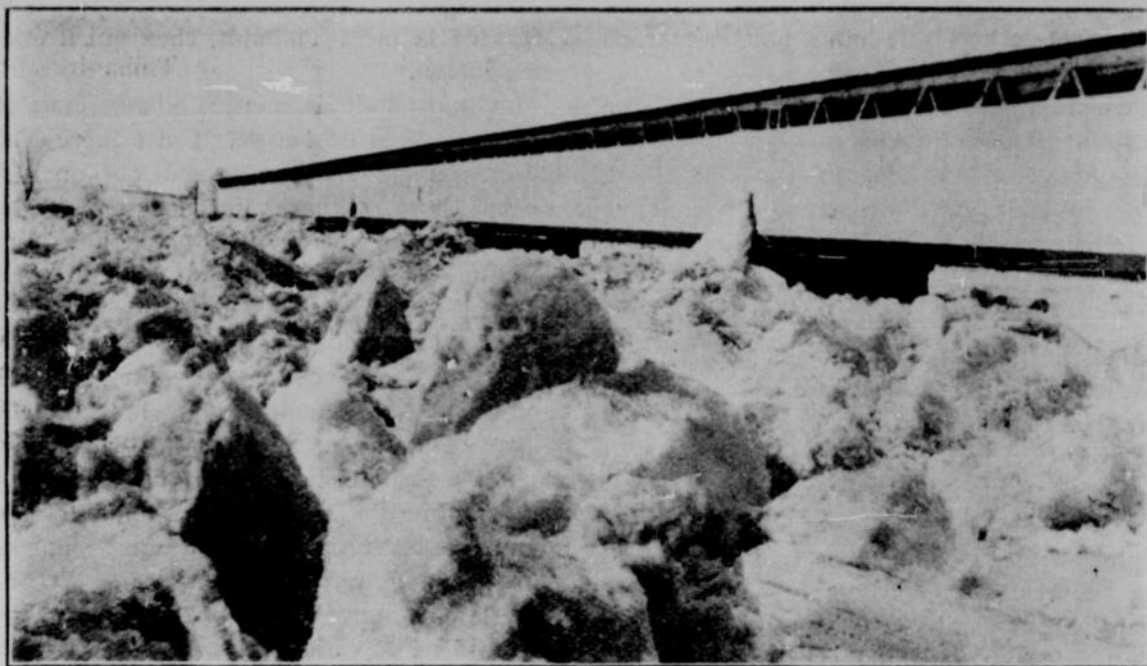
Le pont de Nicolet, P.Q., photographié le 31 mars 1907, par M. J.-A. Dumas, photographe, 460 rue St-Denis, et montrant les glaçons qui compromirent un moment l'existence de ce pont couvert.
