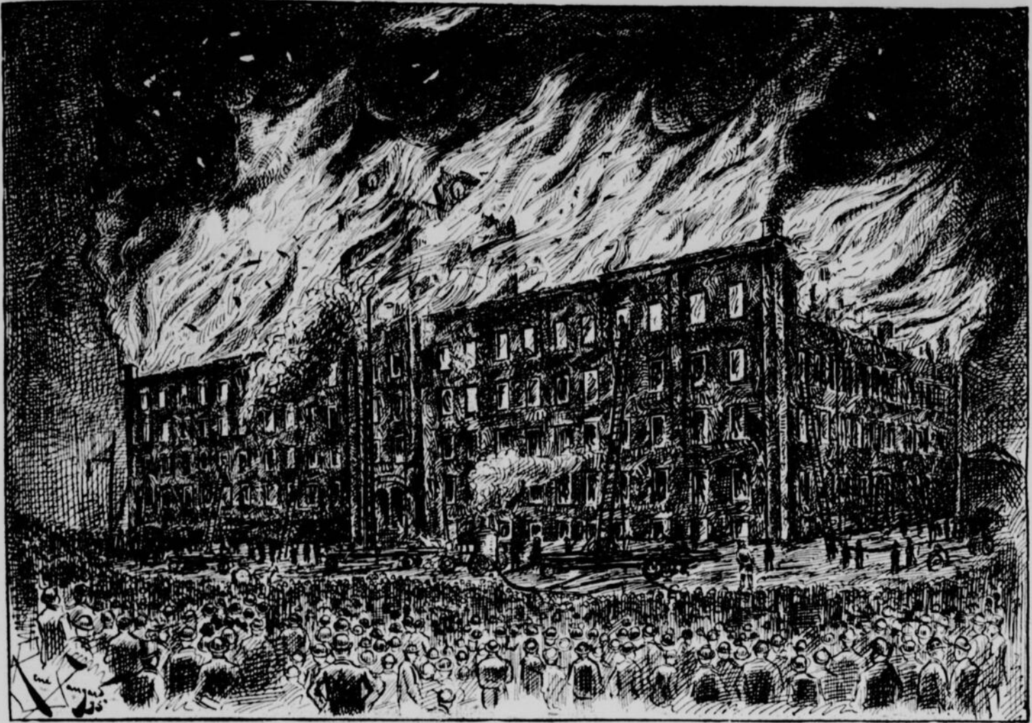
MONTREAL. — INCENDIE DE LA MANUFACTURE DE TABAC MACDONALD. — Croquis de René Sangard
